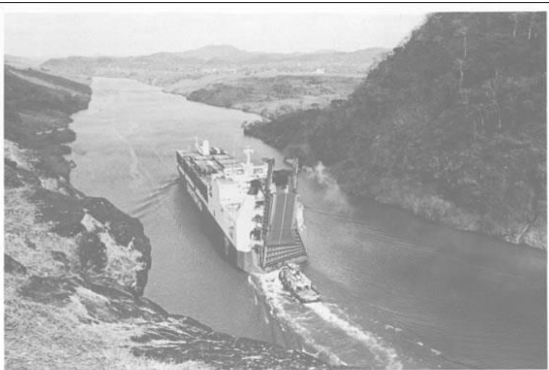
▲ In de «Gaillard Cut».
