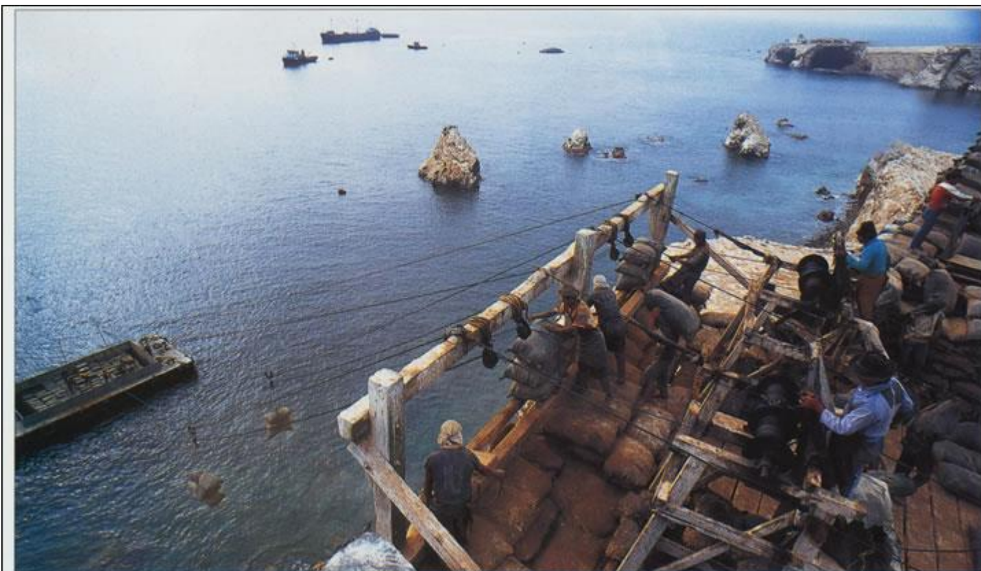
En 1997, lorsque Patrick-Charles Messance réalise ce reportage aux Chinchas, les conditions de travail sont presque aussi éprouvantes qu'au temps des coolies. Des hommes suspendus à des cordes recueillent le guano des falaises, puis transportent les sacs sur leur dos jusqu'à la plate-forme de déchargement.
