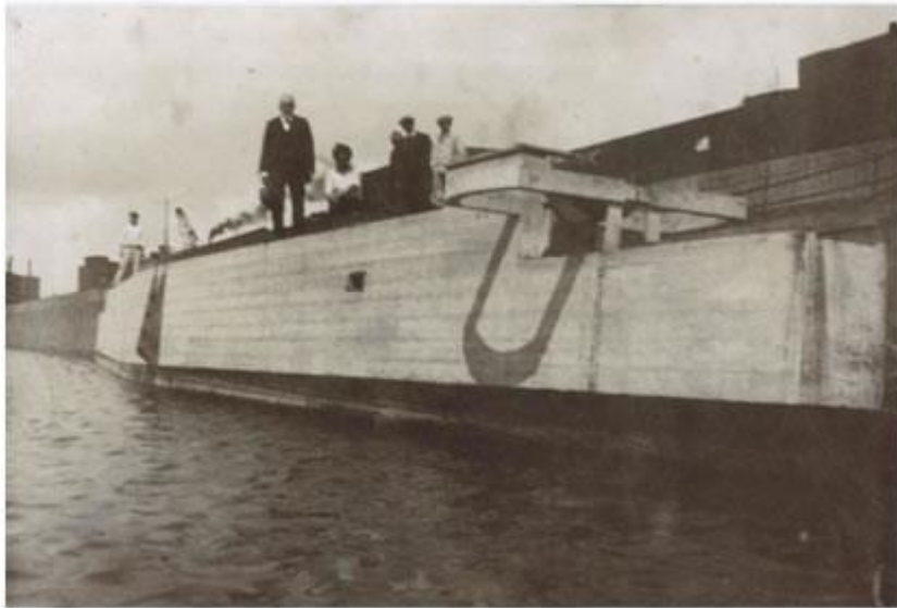
Prototype van de Bateau-Vitesse gebouwd door Hennebique (CNAM/SIAF/CAPa/Archives d'architecture du XXe siècle © Fonds Bétons armés Hennebique)
