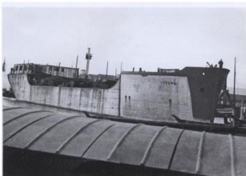
Voorjaar 1952, de Citank wordt bovendeks afgebouwd met herbruikte onderdelen van betonnen barakken van het gehucht Meereigen te Merkssem (foto archief Kerkschip)
